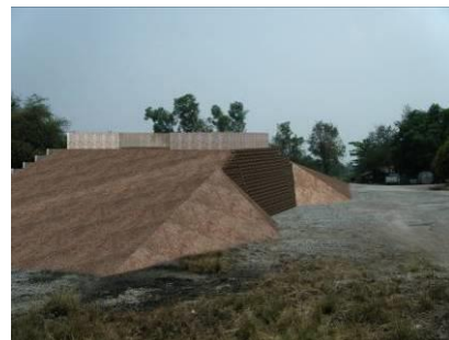
ขั้นตอนที่ 18 การติดตั้งวัสดุเสริมแรง และการควบคุมคุณภาพการก่อสร้างใน ชั้นต่อไป ไปมีขั้นตอนการติดตั้ง เช่นเดียวกันกับการติดตั้งในลำดับก่อน หน้านี้
