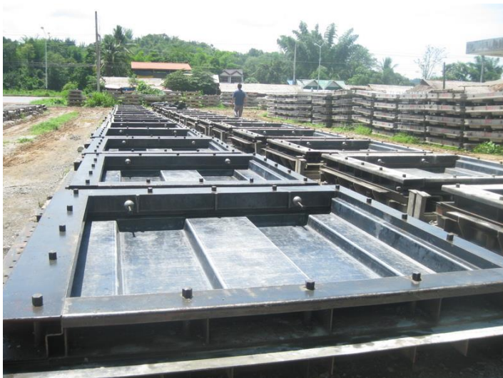
รูปที่ 4.1 แบบเหล็กถูกเตรียมไว้สำหรับการหล่อ Concrete Panel
