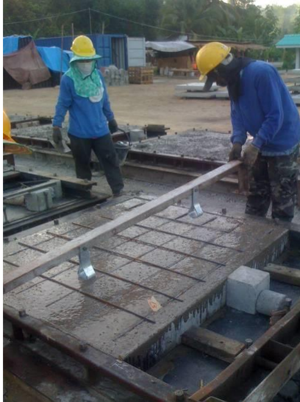
รูปที่ 4.9 การติดตั้งสมอยึดตั้ง
