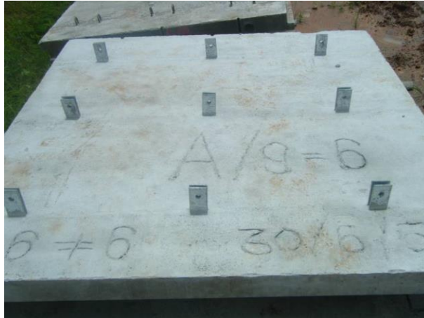
รูปที่ 4.13 แผ่นคอนกรีตภายหลังถอดจากแบบหล่อ
