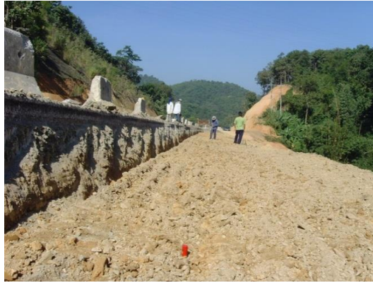
รูปที่ 5.12 การสำรวจเพื่อวางแนวขุดตัดดินเชิงลาด 5.4.4 ขุดตัดลาดไหล่ทาง (Cut Slope) เพื่องานก่อสร้างกำแพงกันดินเสริมแรง MSE Wall
