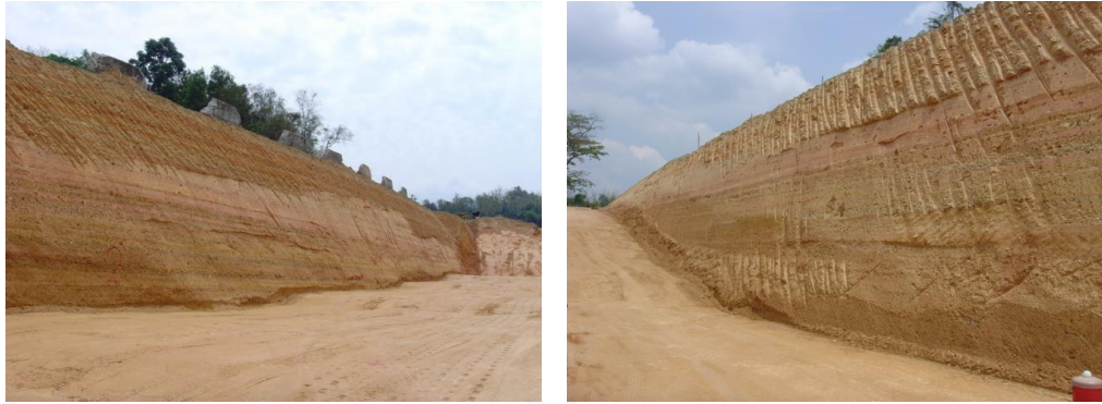
รูปที่ 5.16 การขุดปาดผนังด้าน Back Slope MSE Wall ให้เรียบก่อนปูวัสดุ Geotextile
