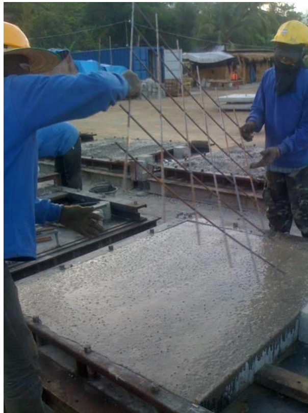
รูปที่ 4.8 การวางแผงเหล็กตะแกรงเหล็กเสริม
